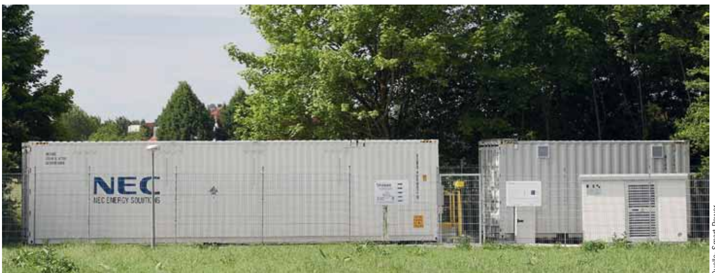
1 Batteriecontainer (links) und Übergabestation mit Wechselrichter- und Mittelspannungsanlage
